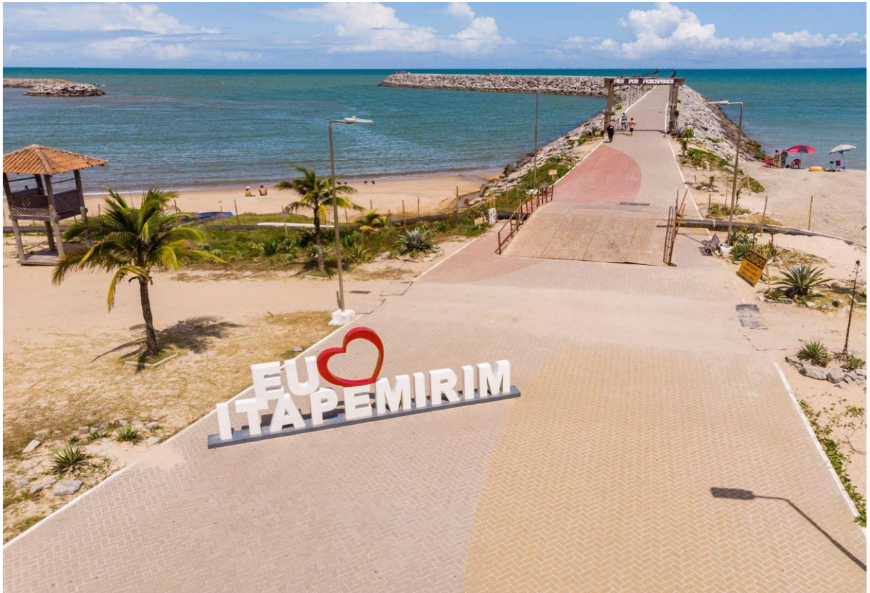
Foto 04: Pier de Itaipava. Fonte: Arquivo Defesa Civil
