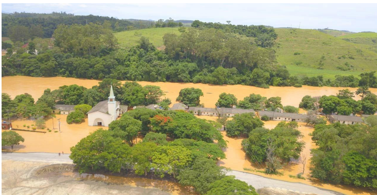
Foto 07: Inundação em 2017 na Comunidade de Paineiras. Fonte: Arquivo Defesa Civil
