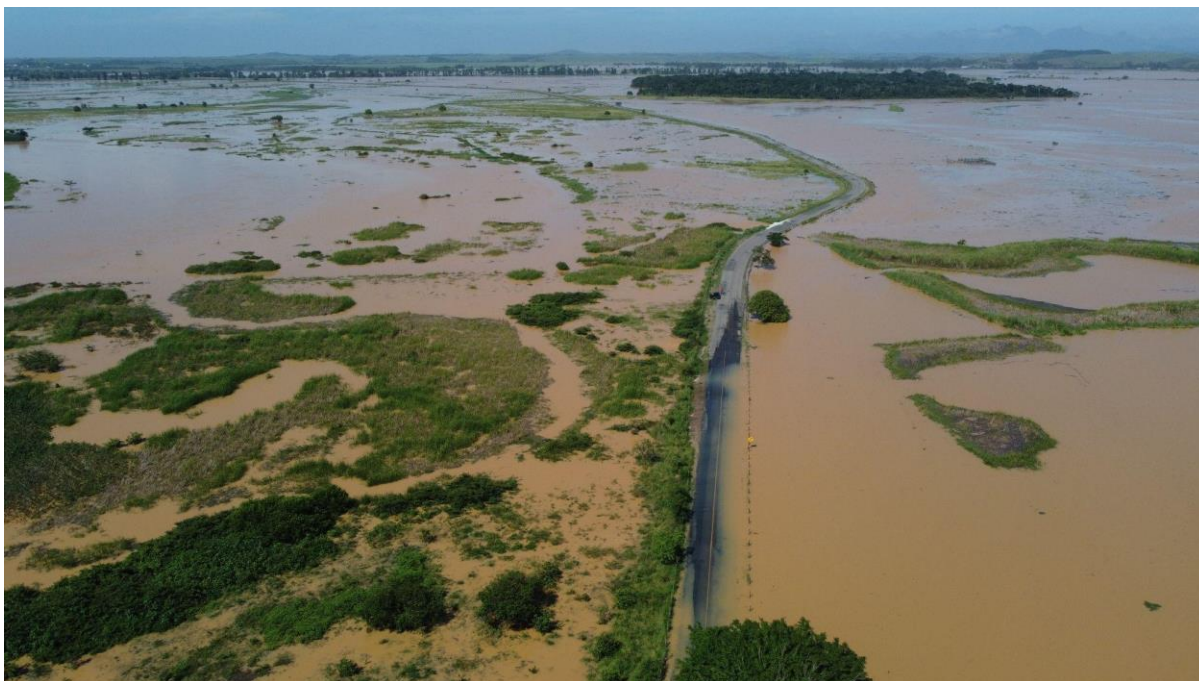
Foto 09: estrada de acesso ao centro administrativo de Vila do Itapemirim alagada (2019). Fonte: Arquivo Defesa Civil
